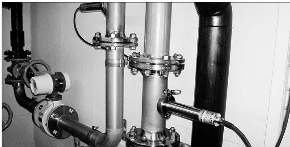
Links im Bild der Zufluss mit Sperrvorrichtung und Durchflusszähler. Die waagrechte Sonde im Vordergrund ist der Trübungswächter. (Bilder: zVg)
