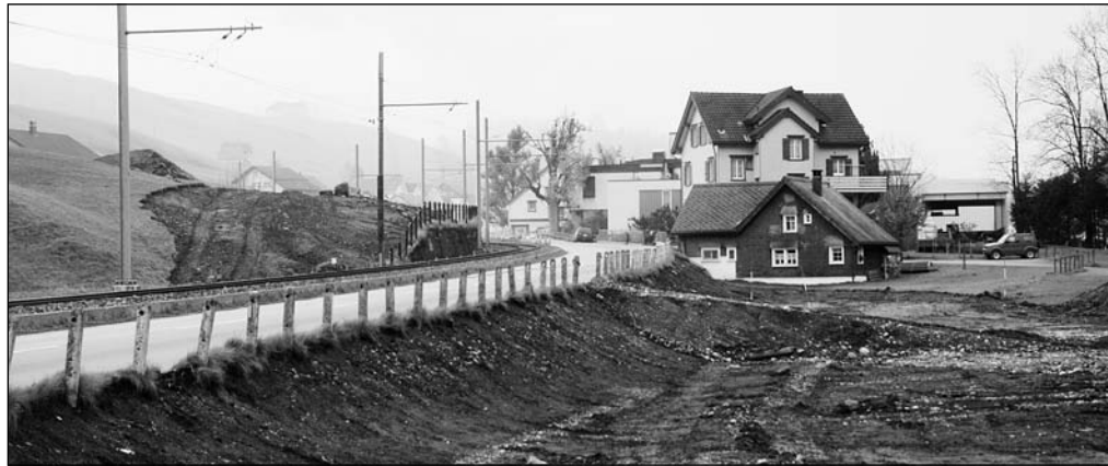
Der frei liegende Hang links der Bahnlinie wird abgegraben, das Material vor Ort wieder eingebaut. (Bild: Rolf Rechsteiner)
